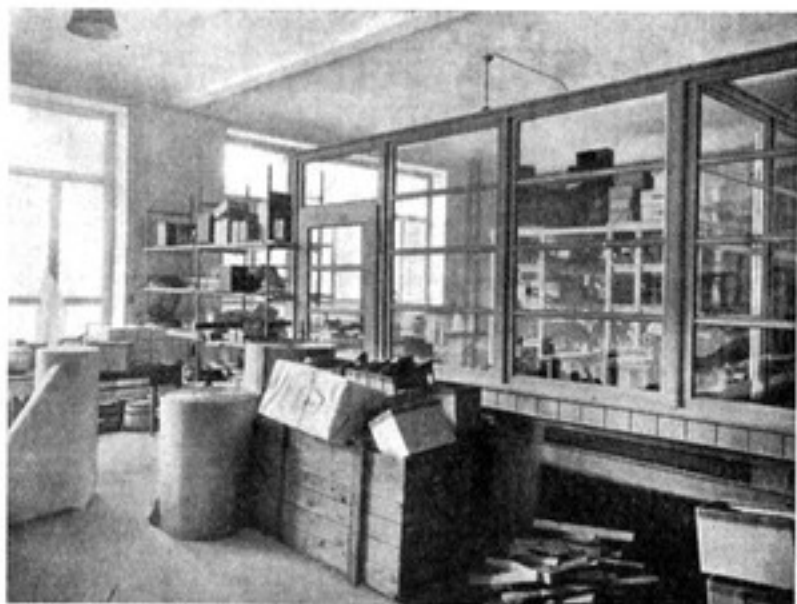
Packerei mit anschließendem Lager
