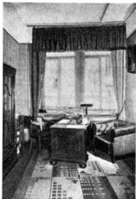
Zimmer der Geschäftsleitung
